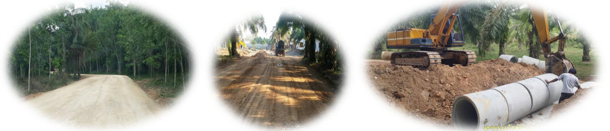
โครงการซ่อมสร้างถนนแอสฟัลท์ติกคอนกรีต สายบ้านควนสาวโตน-น้ำตกห้วยรากไม้
