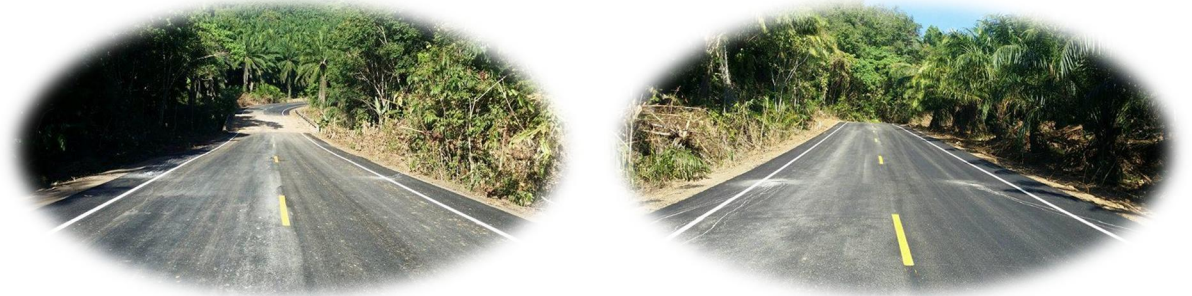
โครงการก่อสร้างถนน คสล.สายบ้านทับหัวกา หมู่ที่ ๕
